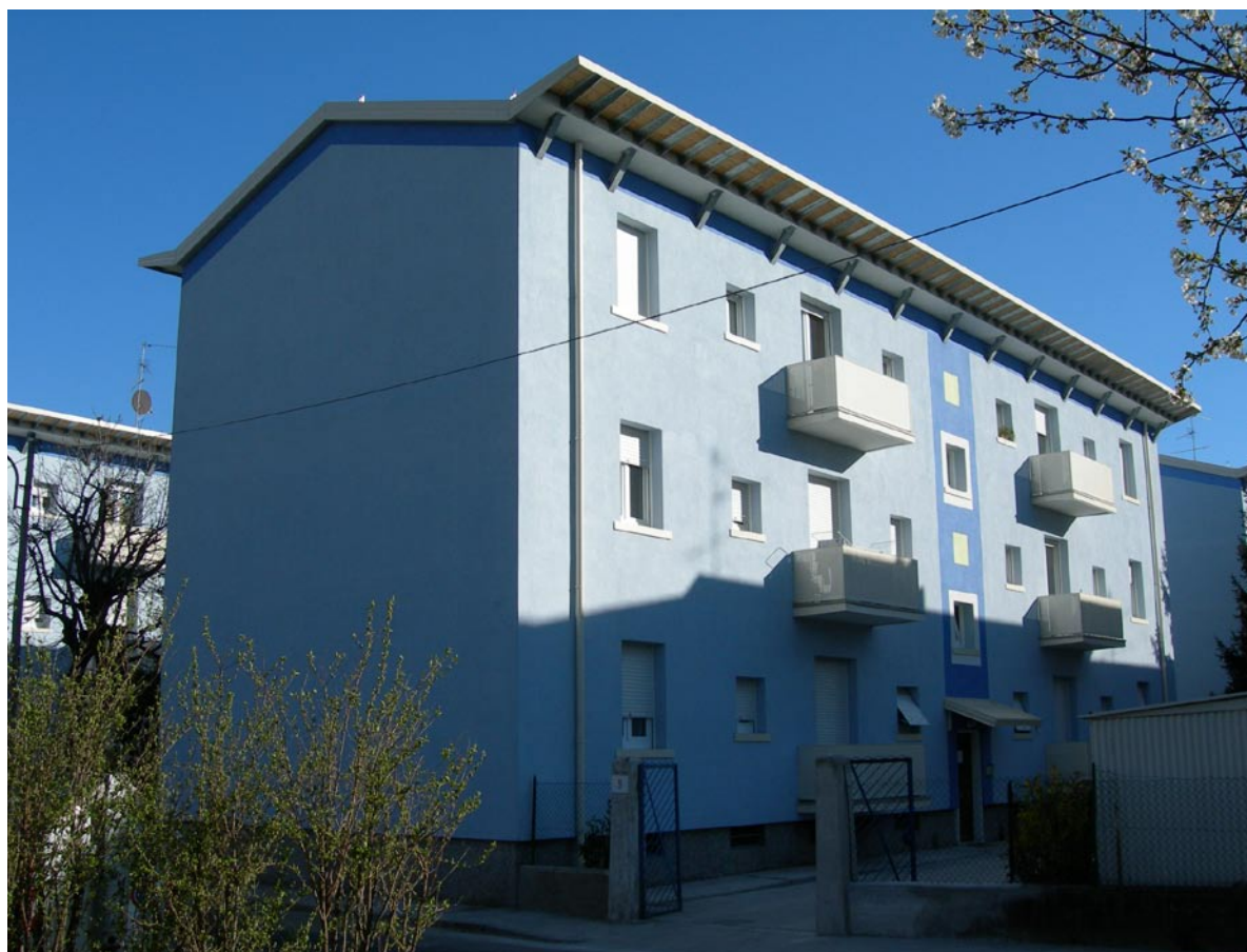
Il quartiere San Bartolomeo di Brescia prima (sotto) e dopo l'intervento di recupero energetico, realizzato dall'Aler bresciana assieme al Comune.
