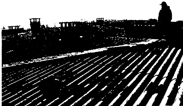
Alcune case Aler con i tetti in eternit
